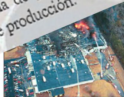
La fábrica de goma Farmacéuticos West en llamas después de explosiones de polvo.
